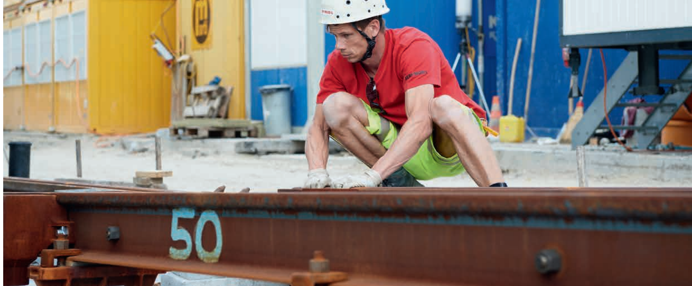
Christian Kämpf bei der Montage der neuen Tramschienen am Eigerplatz.
