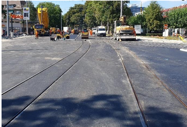
Abb. 17 Bauprojekt KTM – Gleiswechsel
