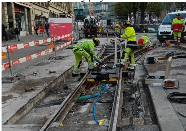
Abb. 18 Bauprojekt Hirschengraben, Abzweiger Wallgasse
